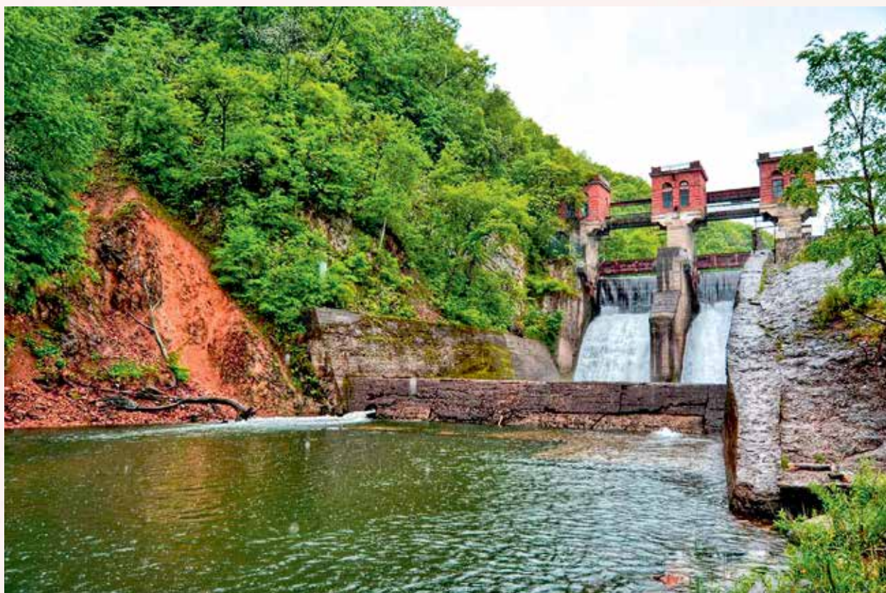
Водосброс Партизанской ГРЭС
